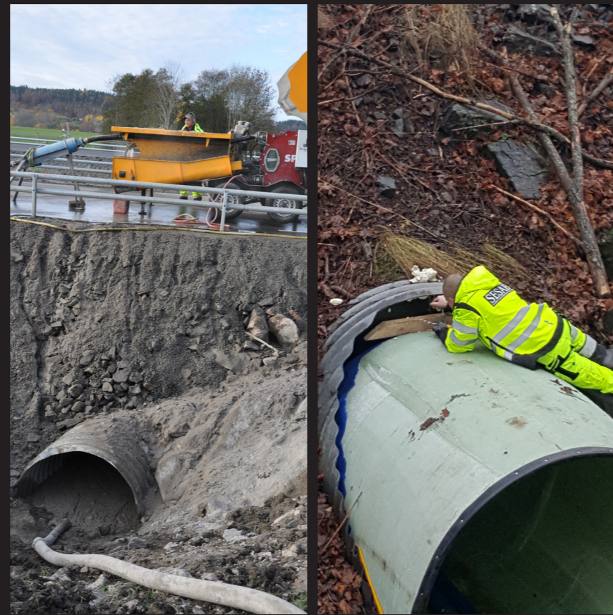
Stabilisering / isolering av rör
