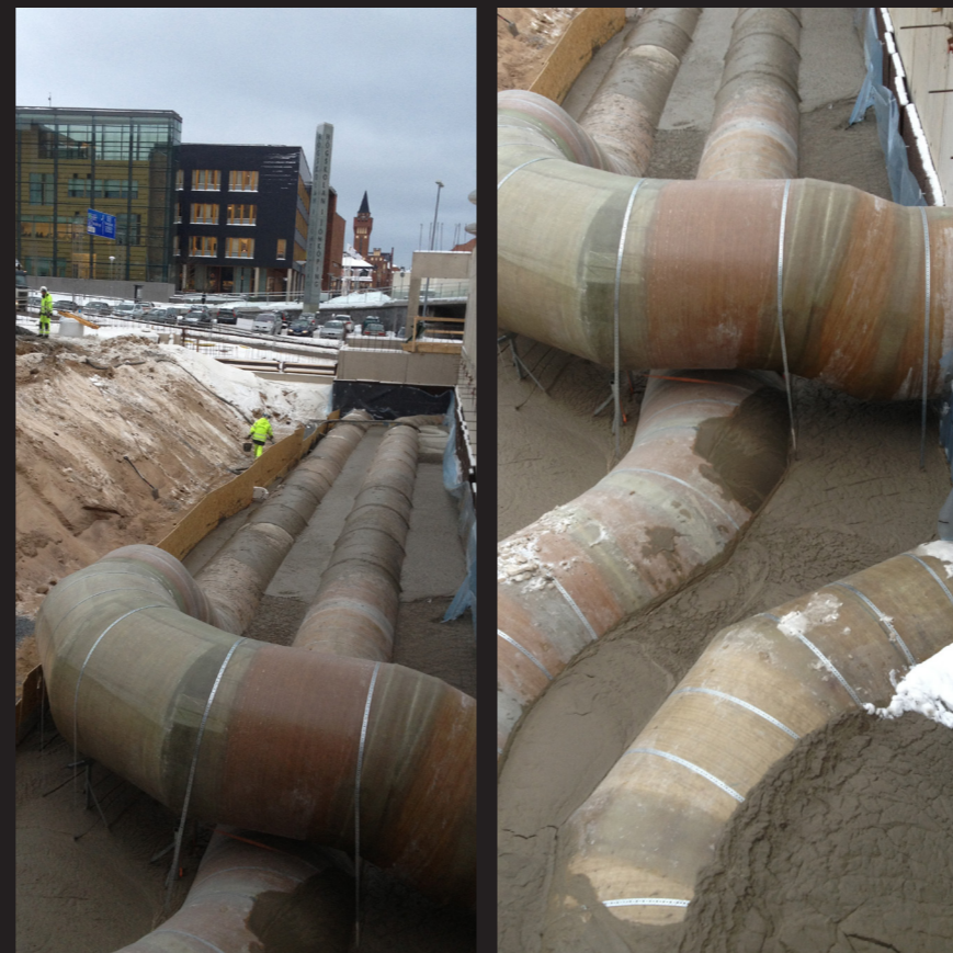
Stabilisering / isolering av rör
